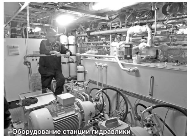
Оборудование станции гидравлики
