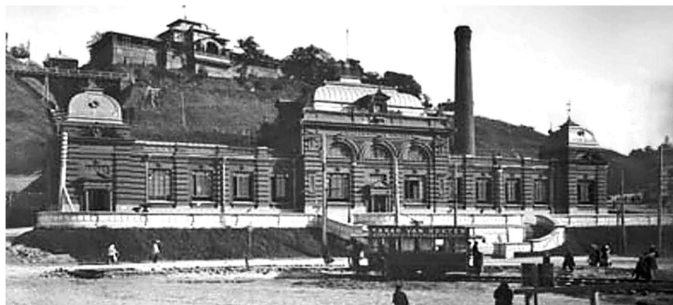
Здание электростанции напротив Канавинского моста, в котором с 1941 по 1965 год размещался завод «Ротор» (№238). В годы Великой Отечественной войны здесь изготавливали генераторы для сормовских танков Т-34
