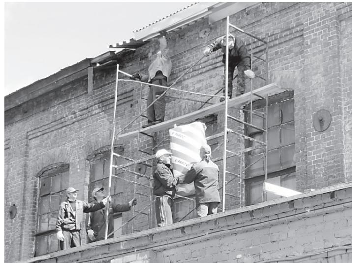
Работы по замене несущего настила покрытия 1-го пролёта ремонтно-механического участка ПСТ выполняет ООО «Технострой»
