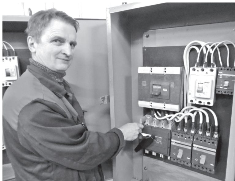
Специалист 6 разряда Сергей Русаков, возглавляющий бригаду электромонтёров электроремонтного участка ЭСЦ, выполняет электромонтаж силовых щитов для дробеструйной установки в цехах СКМ и СК-7
